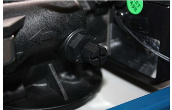
Die Anlage muss bei geschlossenem Umgehungsventil und geschlossener Resthärteeinstellschraube 0° bis max. 0,5° weiches Wasser liefern. Wenn Sie ein Wasser mit Resthärte wollen, müssen Sie die Resthärteeinstellschraube im Uhrzeigersinn drehen, bis die Wasserhärte mit der von Ihnen gewünschten übereinstimmt. ( Empfehlung 6-8°dH im Haushalt ) Die Resthärteeinstellung und Überprüfung muss bei gleichbleibender Wasserzapfmenge vorgenommen werden.
